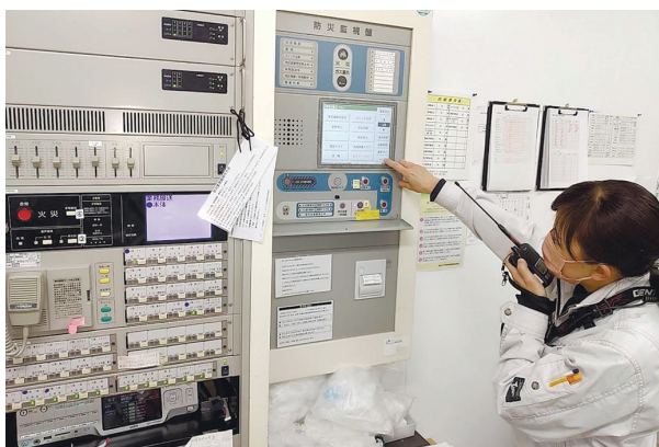
火災報知器点検の様子
